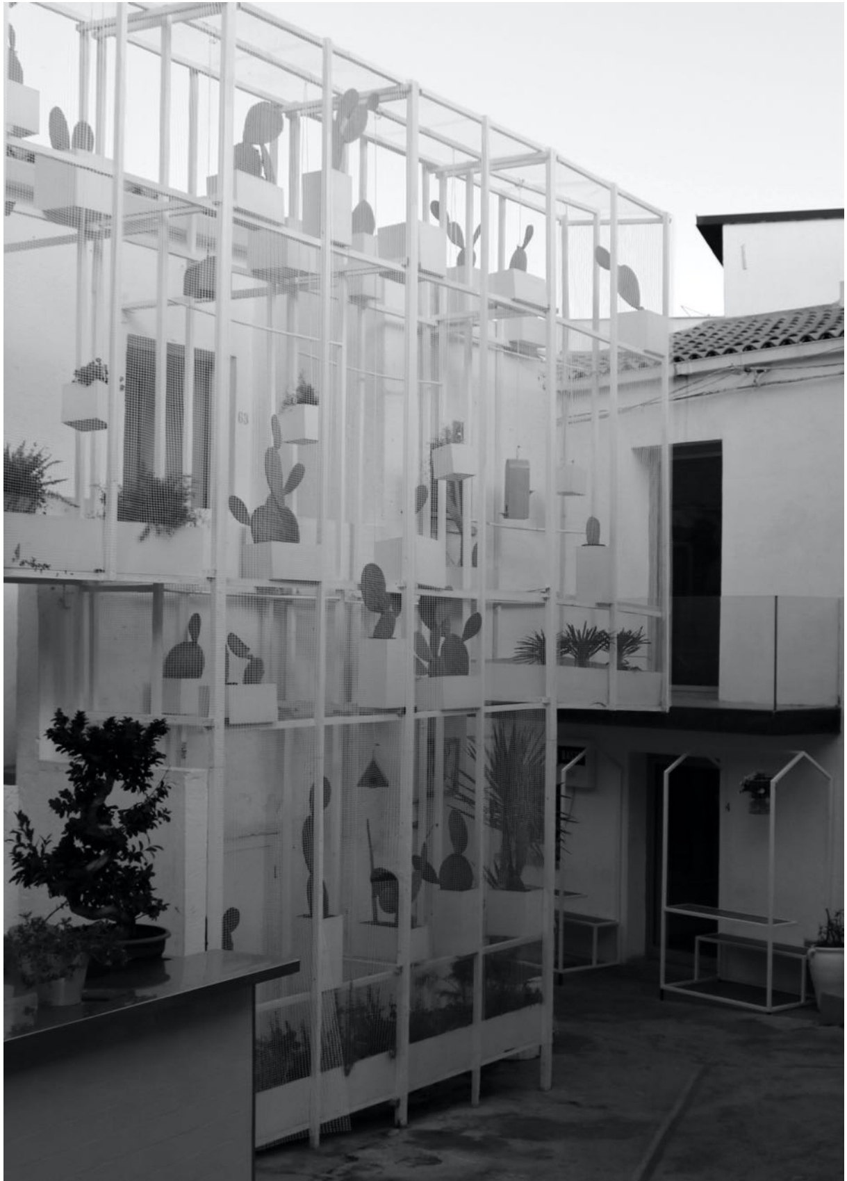
Figura 13. Rinascite . Una seconda pelle realizzata con materiali di recupero per uno degli edifici riabilitati nel Farm Cultural Park , Favara, Agrigento.
